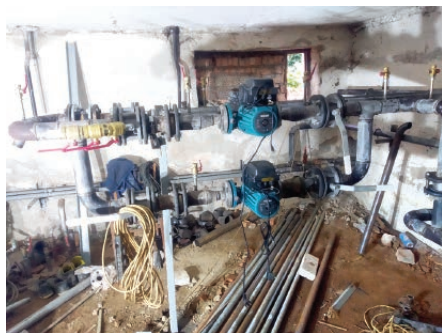
Фото 2. Ремонт индивидуального теплового пункта в многоквартирном жилом доме по ул. Центральной, 3 в г. Жабинка
