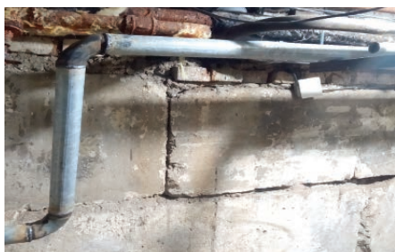
Фото 3. Замена трубопроводов и тепловой изоляции в подвальном помещении многоквартирного жилого дома по ул. Центральной, 4 в г. Жабинка
