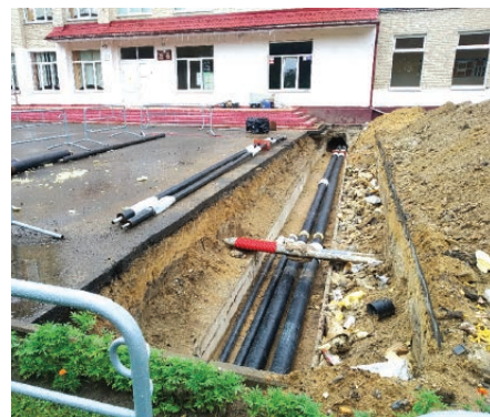
Фото 1. Замена участка теплотрассы на территории средней школы № 2 в г. Жабинка
