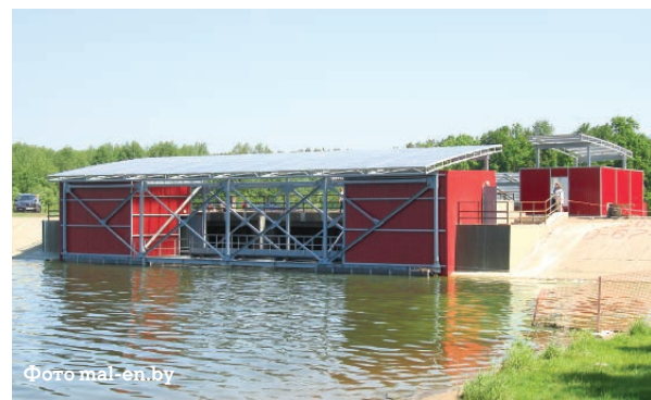
Малая ГЭС водосброса водохранилища «Дрозды»
