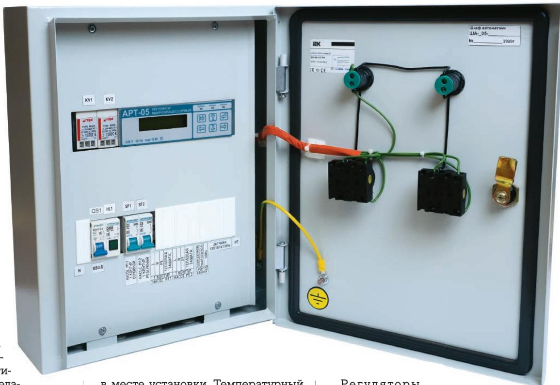
в месте установки. Температурный график может быть построен в автоматическом режиме с возможностью корректировки по константе или по 12 точкам либо вручную. Недельный график позволяет корректировать режим работы системы теплоснабжения по часам и дням недели, а годовой график праздничных дней – задать сразу на весь год необходимые изменения в работе системы с учетом праздников и переносов рабочих дней.
