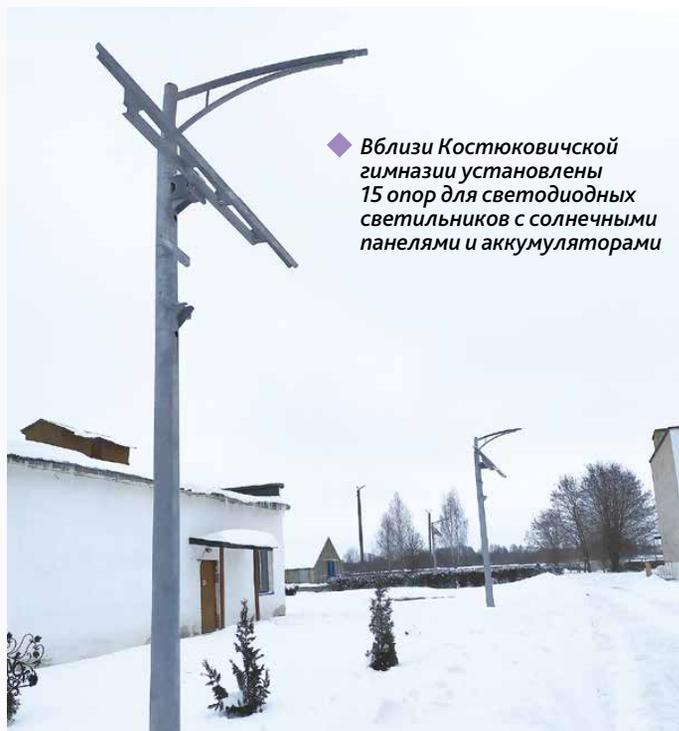
◆ Вблизи Костюковичской гимназии установлены 15 опор для светодиодных светильников с солнечными панелями и аккумуляторами
