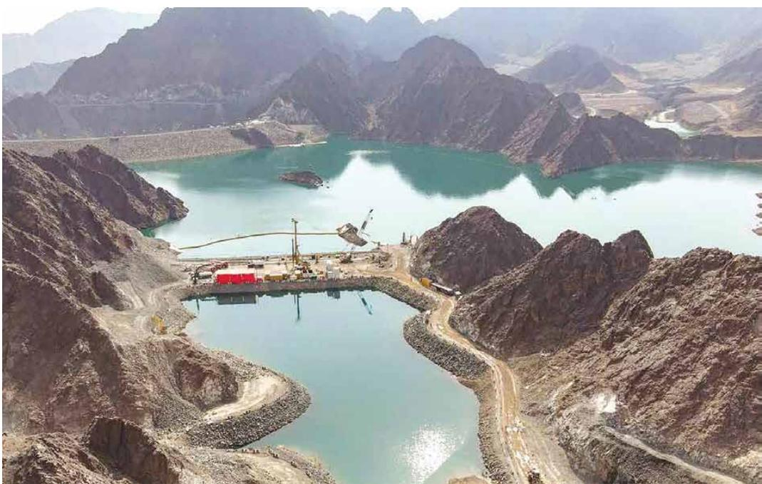
◆ *Строительство первой в регионе гидроаккумулирующей электростанции, которая будет производить электричество за счет накопленной энергии воды из водохранилища «Hatta Dam», общей мощностью 250 МВт и сроком эксплуатации 80 лет*
