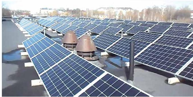
◆ 135 солнечных панелей общей мощностью до 50,8 кВт располагаются на крыше здания гимназии
