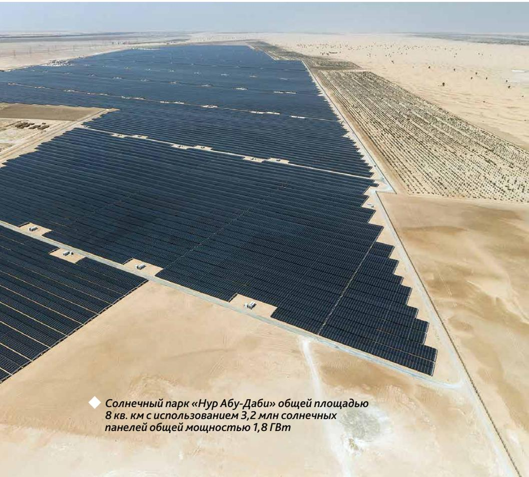
◆ Солнечный парк «Нур Абу-Даби» общей площадью 8 кв. км с использованием 3,2 млн солнечных панелей общей мощностью 1,8 ГВт
