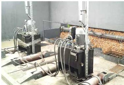
В декабре 2021 года на ул. Рабоче-Крестьянской на территории котельной Осиповичского УКП ЖКХ после завершения строительства введен в эксплуатацию отдельный модуль с установленным в нем котлом, работающим на местных ТЭР. Тепловая мощность энергоисточника – 3,0 МВт, планируемый объем использования местных топливно-энергетических ресурсов – 1400 тонн условного топлива.
